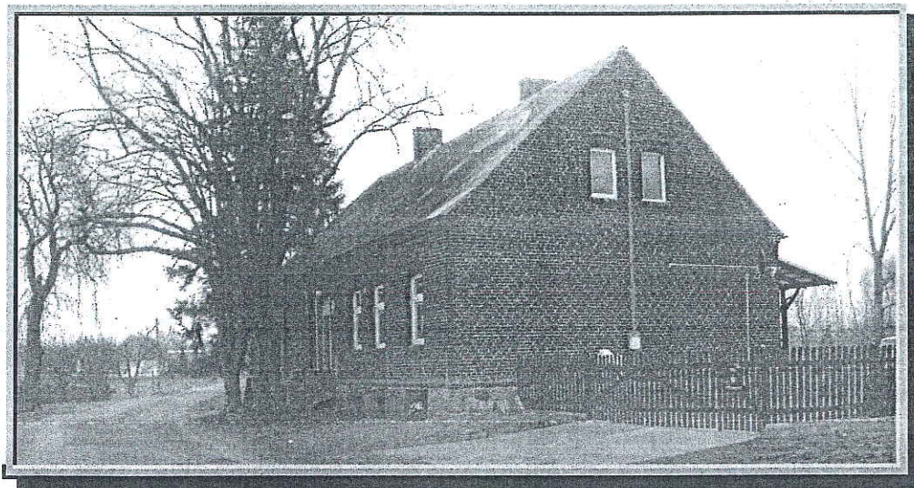
Rys.11. Budynek byłej szkoły w Gołąbkach.
