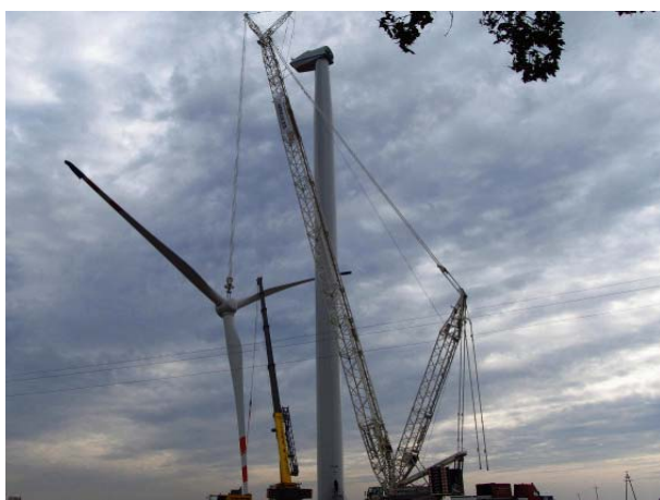
Rys. 111. Montaż elektrowni wiatrowej w miejscowości Ostrowite w 2011 roku źródło: sebekfireman.bikestats.pl
