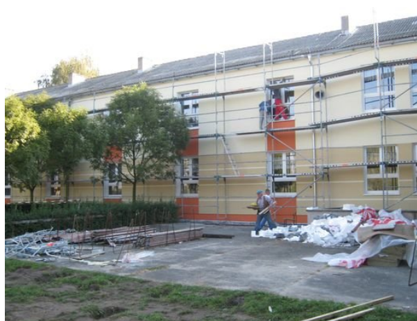
Rys. 85. Prace dociepleniowe budynku Zespołu Szkół w Trzemżalu źródło: www.trzemzal.pl
