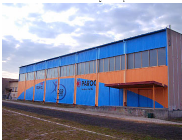
Rys. 89. Hala widowiskowo-sportowa źródło: wegner.pl
