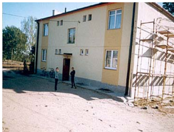
Rys. 91. Budynek Spółdzielni Mieszkaniowej w Kruchowie źródło: wegner.pl
